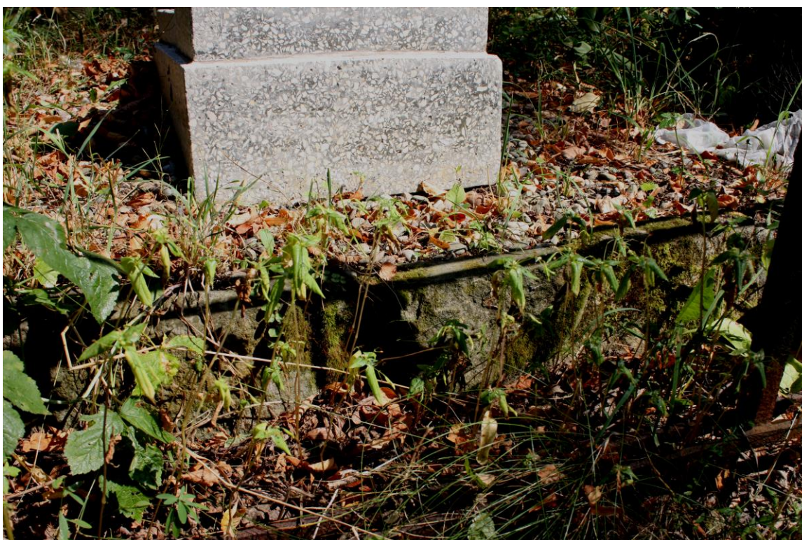
19. Fragment muru oporowego- piaskowcowego na granicy cmentarza wojennego i komunalnego.
