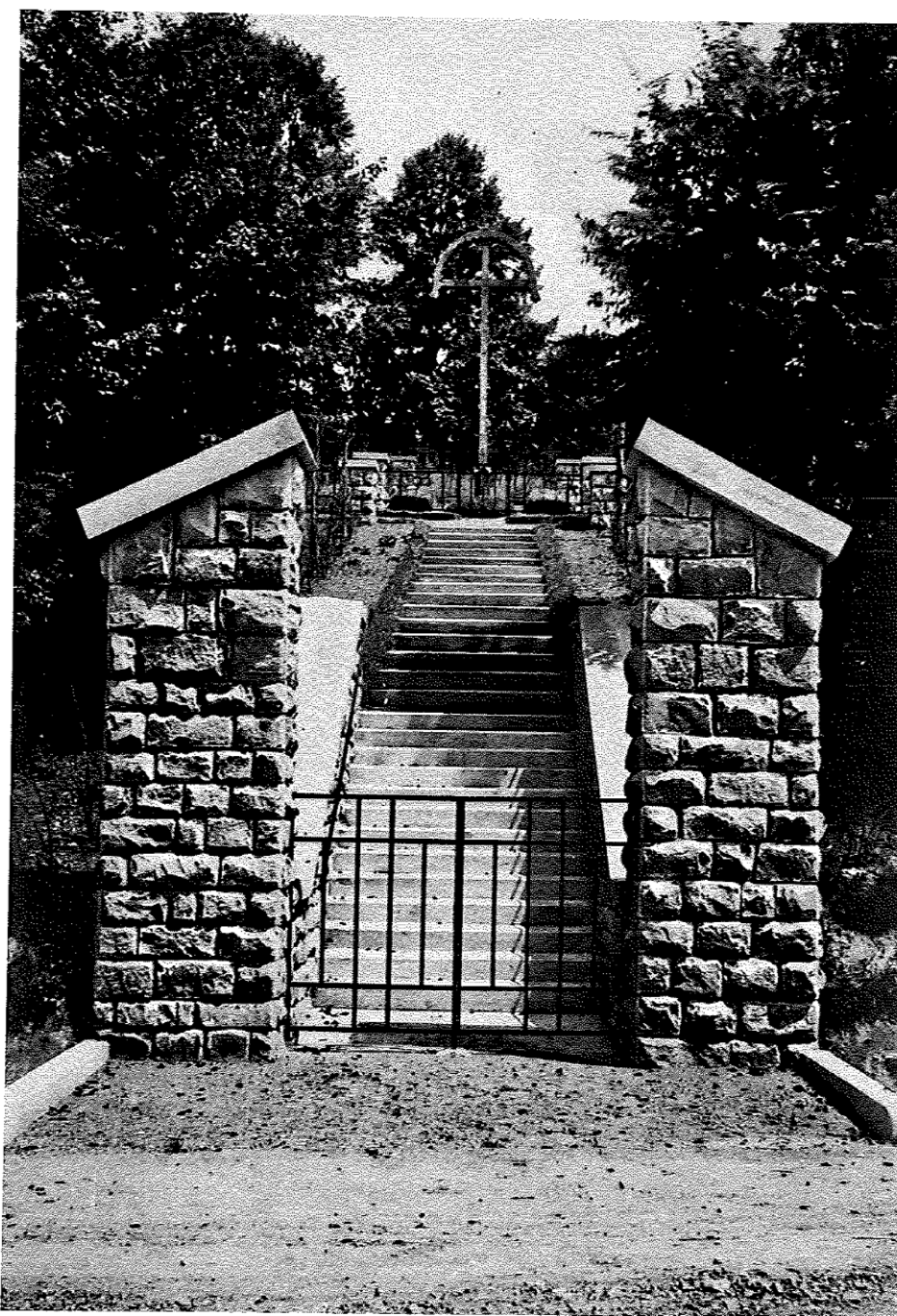
Fot.1. Fotografia archiwalna z lat 1916- 1918. Widok cmentarza z drogi Zaborowice – Bobowa. Wejście z pierwotną dwuskrzydłową kutą furką.
