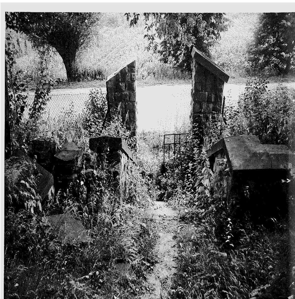
Fot. 2. Mury schodów wejścia z furtką dolną – widok od płyty cmentarza
