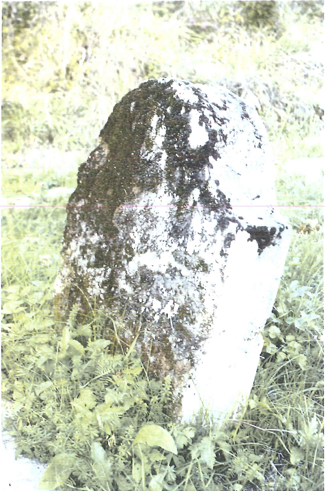
Fot.6. Maceba z nawarstwieniami pochodzenia biologicznego
