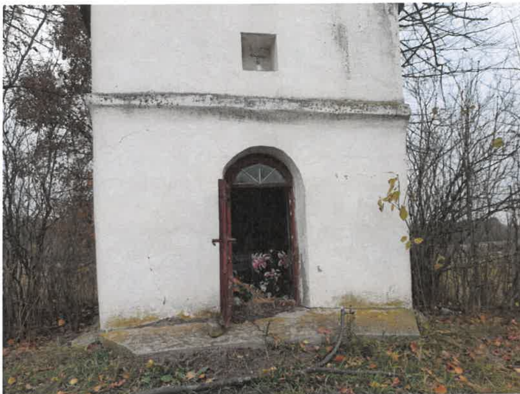
Fot.3 Kapliczka w Stróżnej .Widok ogólny ; elewacja frontowa –fragment. Stan ;Listopad 2019
