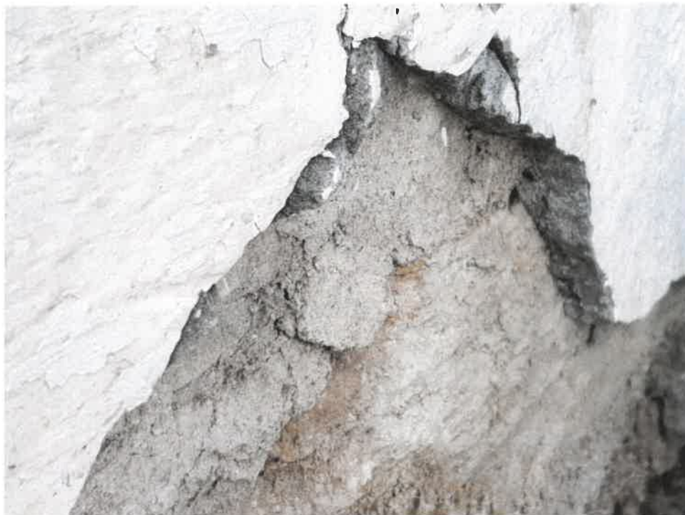
Fot.8 Kapliczka w Stróżnej .W odkrywce pod warstwą betonu grubości do 2cm. widoczne historyczne pobiały oraz wążek kamienny. Stan ;Listopad 2019
